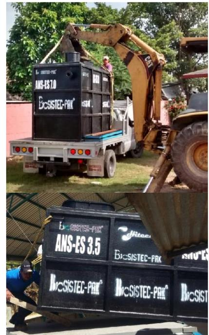
Los sistemas sépticos construidos y prefabricados incluyendo la planta BIOSISTEC-PAK<sup>®</sup> serie ANS-ES, necesita instalarse con un sistema de tratamiento en suelo o campo de absorción u oxidación, el conjunto del sistema séptico y el campo de absorción, es el que realiza el tratamiento de agua.
